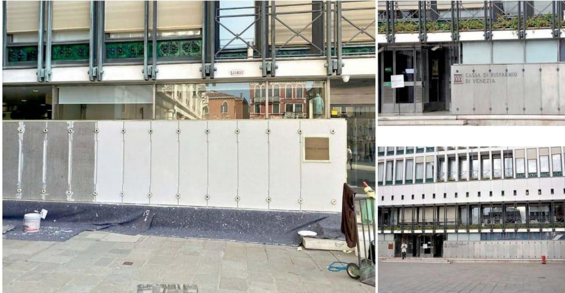
La tinteggiatura in corso sul basamento del palazzo della Cassa di risparmio, in campo Manin. Le foto, scattate da un architetto veneziano, sono finite sul tavolo della Soprintendenza. A destra, il basamento del palazzo prima dei lavori in corso. Sotto, ancora due immagini dei lavori di tinteggiatura in corso ieri pomeriggio
